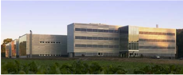
Das neue Produktionsgebäude der Stoppani AG, Neuenegg
